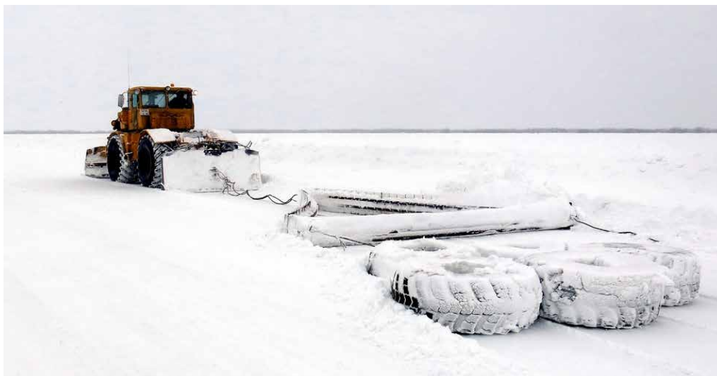
Рис. 1. Предварительное уплотнение снега
